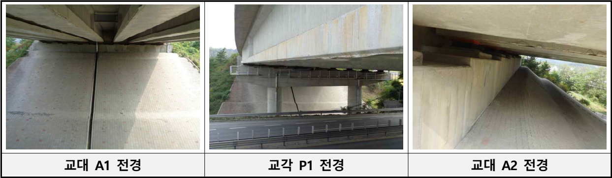
[교대 및 교각 전경]
