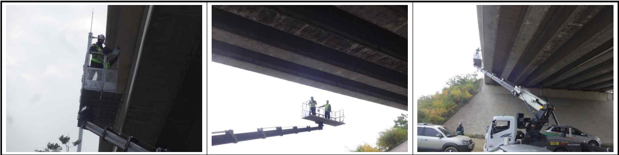
[고소작업차를 이용한 근접조사 실시]
